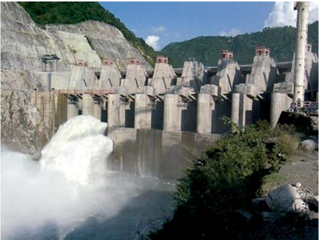
Vishnuprayag Barrage Site
