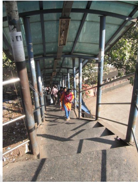
Fig. (b). Stairway (S2)
