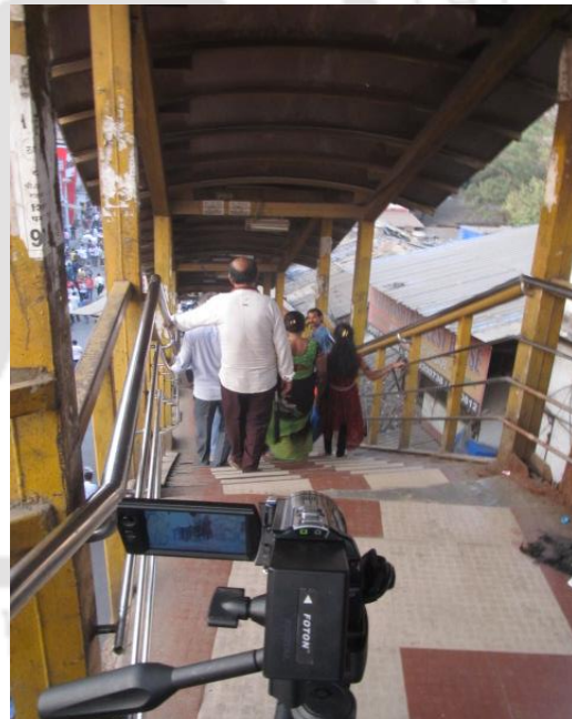
Fig. (b). Stairway (S7)
