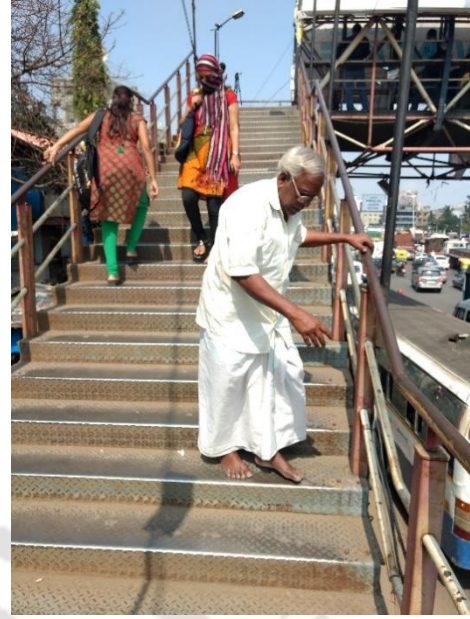
Fig. (b). Stairway (F13)
