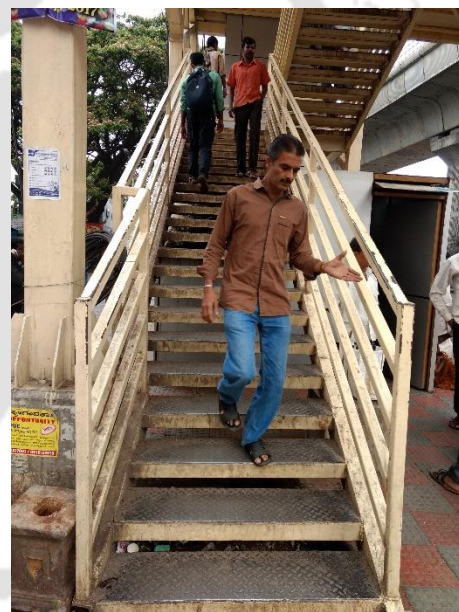
Fig. (b). Stairway (F14)
