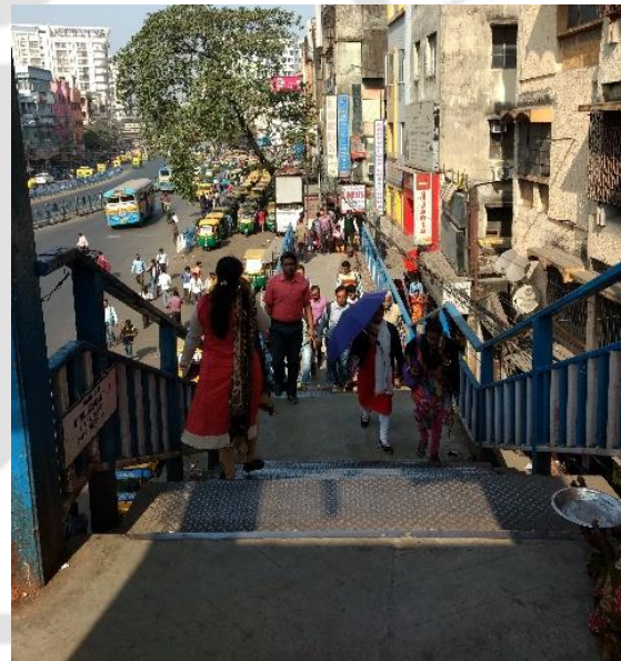
Fig. (b). Stairway (F5)
