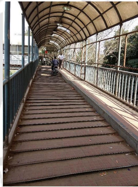
Fig. (b). Stairway (F11)
