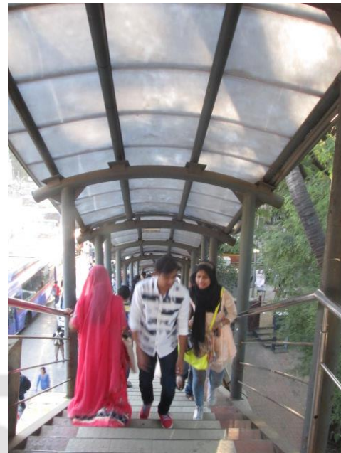
Fig. (b). Stairway (F4)
