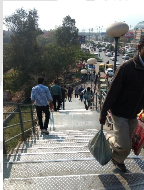
Fig. (b). Stairway (F9)
