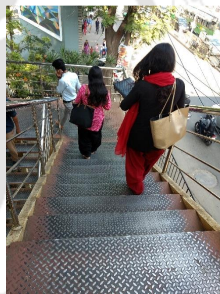
Fig. (b). Stairway (F16)
