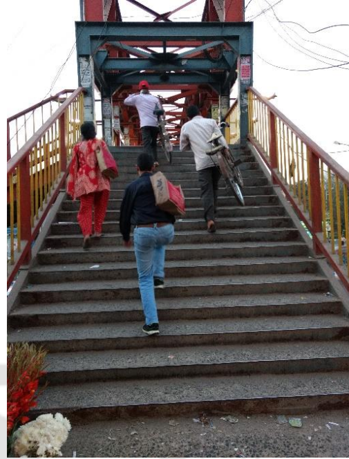
Fig. (b). Stairway (F6)
