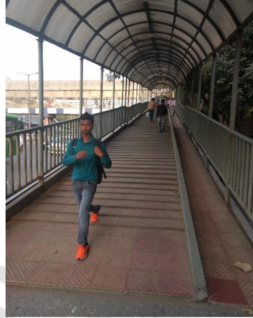
Fig. (b). Stairway (F10)
