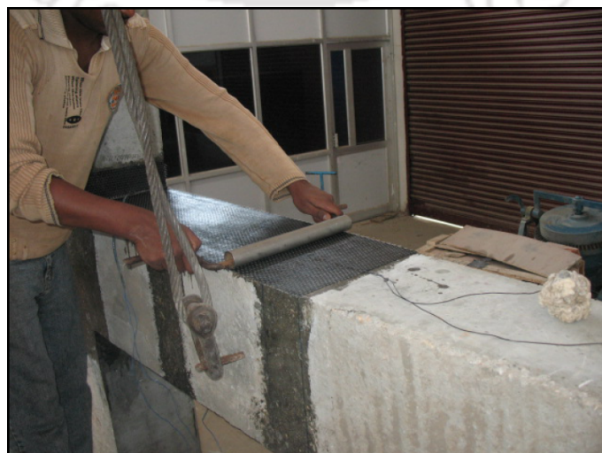
Fig. 3.12 Rolling over FRP
