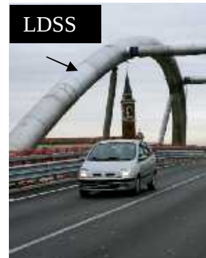
Figure 1. 7: Piove di Sacco Bridge, Padua ( www.szs.ch )
